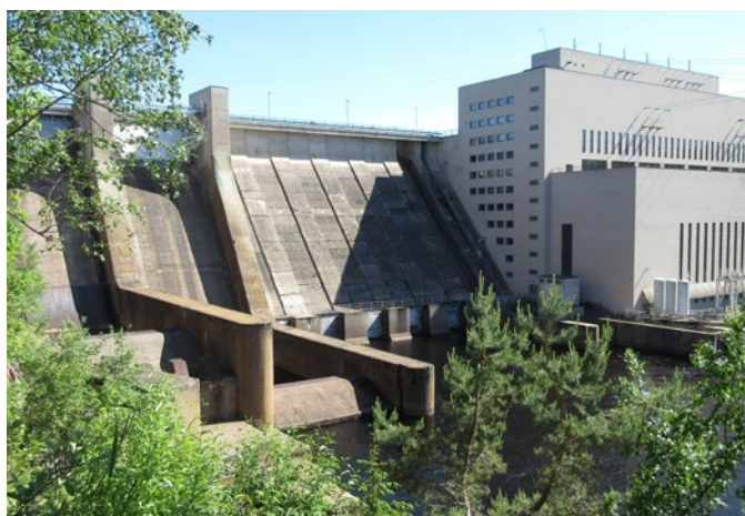
Расположенная на территории геопарка гидроэлектростанция. © tunturisuus / Pixabay.com
